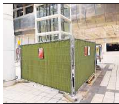
Seit Mai wird am Aufzug zu Gleis 1 gearbeitet. Ab Freitag soll er wieder funktionieren. FOTO: RSK
